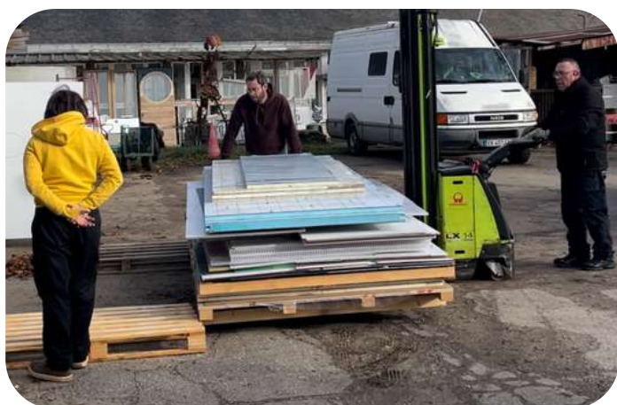
Livraison sur site de l'entreprise Prolians
